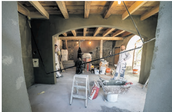
Der fast fertig renovierte Eingangsbereich.
