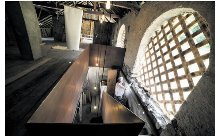
Die neu eingebaute Treppe.
