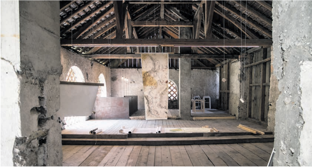
Blick in den sanft renovierten Veranstaltungssaal im Obergeschoss.
